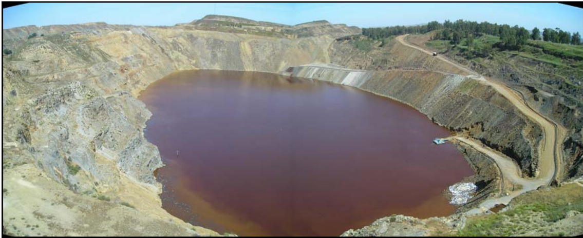
Figura 7.9. Corta de Aznalcóllar en julio de 2006, durante el vertido de la escombrera de pirita S-3.
