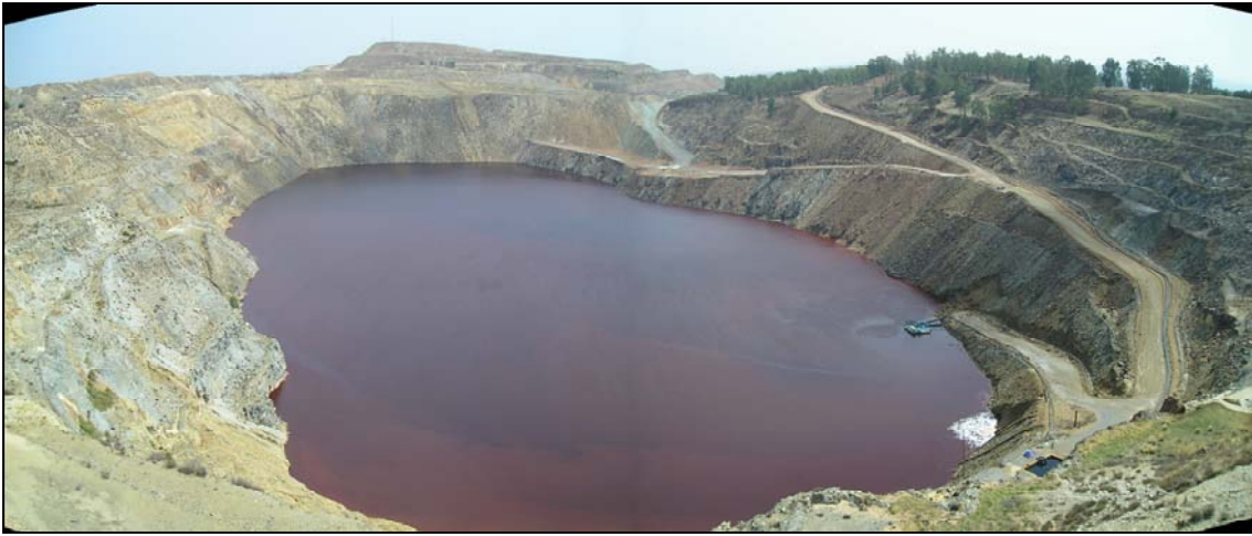
Figura 7.11. Corta de Aznalcóllar en septiembre de 2007, tras la finalización del vertido de la escombrera de pirita S-3.
