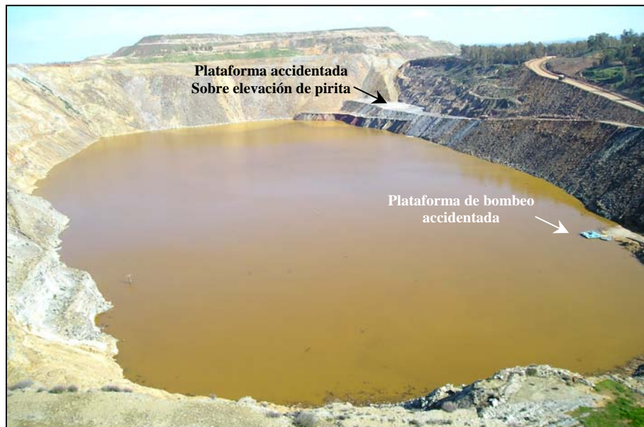
Figura 7.6. Situación de la corta de Aznalcóllar en marzo de 2006, después del derrumbe parcial de la plataforma de vertido.
