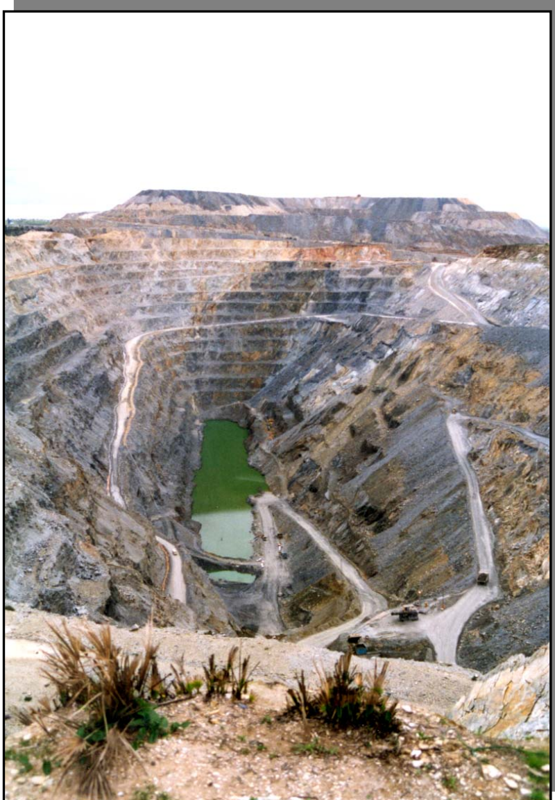
Figura 7.1. Vista de la corta de Aznalcóllar desde el Oeste al final de su explotación. Sobre el lado oriental se inició su relleno con los estériles procedentes del yacimiento Los Frailes en el año 1995. Al fondo se observa la escombrera Este.
