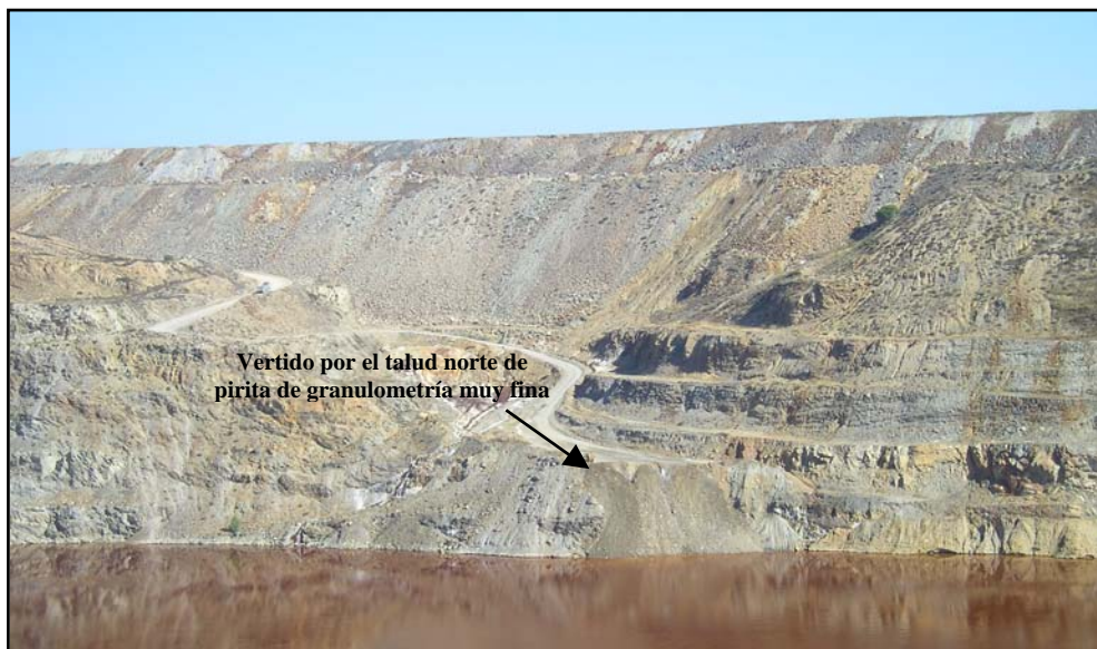
Figura 7.8. Talud norte de la corta de Aznalcóllar en mayo de 2006, durante el vertido de pirita de granulometría muy fina, almacenada en el área industrial.
