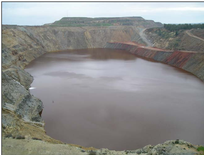
Figura 7.10. Corta de Aznalcóllar en noviembre de 2006, tras la finalización del vertido de la escombrera de pirita S-3.
