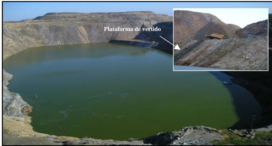
Figura 7.5. Corta de Aznalcóllar en enero de 2006, al comienzo del vertido de la escombrera de pirita S-3.
